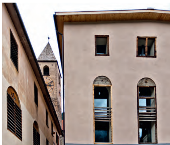
Ursprünglich ein Heustall und energietechnischer Albtraum: Haus Tablà in Ramosch.
